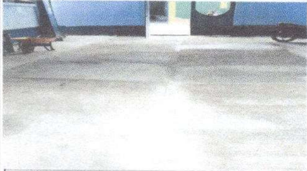
Foto 7: Reparación de plancha de concreto de patio
