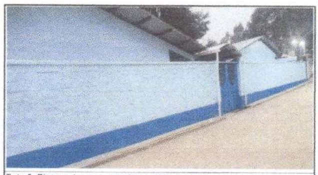
Foto 6: Pintura de muro exteriores e interiores
