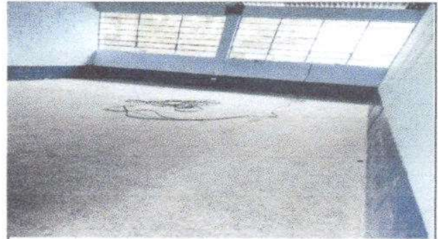
Foto 2: Sustitución de piso de granito
