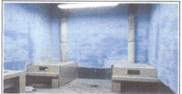
Foto 12: Colocación de 2 Chimenas de Concreto
