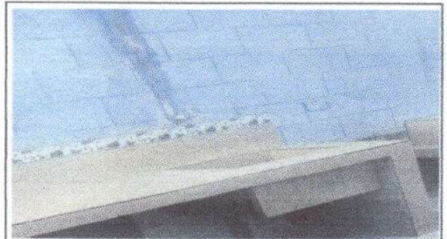
Foto 10: Sustitución de pila de concreto de un lavadero
