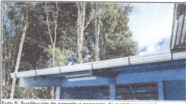
Foto 5: Sustitución de soporte o pescante de metal para canal
